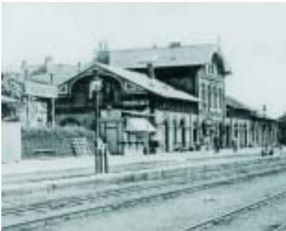
DER MARSCHBAHNHOF VON 1887 – Auch er wurde an das Leitungsnetz angeschlossen.
