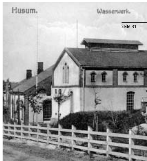
WASSERWERK ROSENDAHL (anno 1902).
