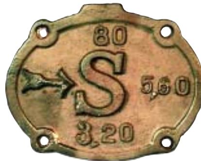
ALTES HINWEISSCHILD AUS GUSSEISEN – Es weist auf die Lage des Wasserschiebers hin.
