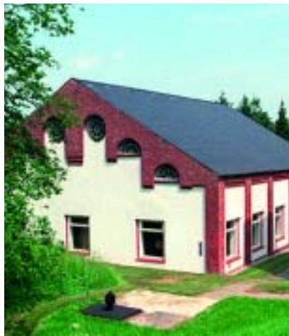
DAS HUSUMER WASSERWERK IN ROSENDAHL HEUTE — Das Bauwerk von 1902 leistet immer noch seine guten Dienste.
