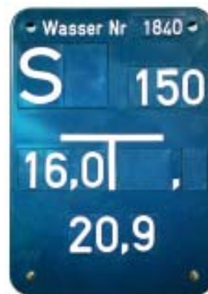
EIN MODERNES HINWEISSCHILD – Es weist auf die Lage eines Wasserschiebers hin.
